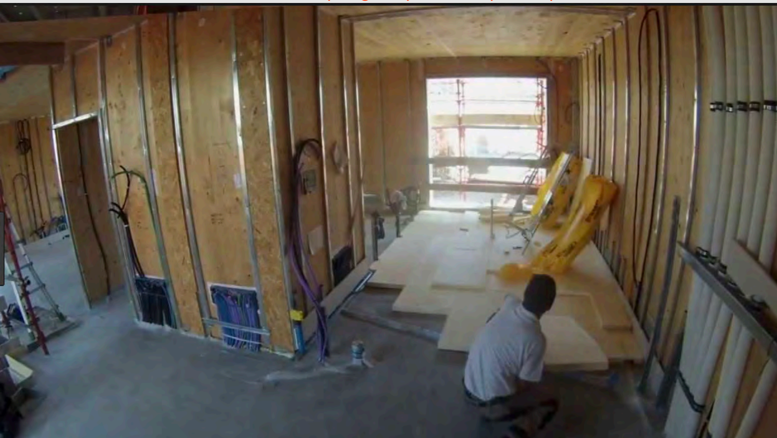
Tipologie di previsione/posa impianti elettrici in costruzioni in muratura
