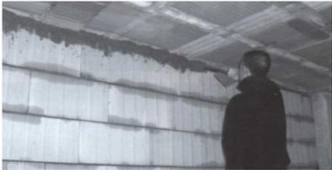
È di fondamentale importanza sigillare adeguatamente con malta la connessione superiore tra parete e solaio (o trave)
