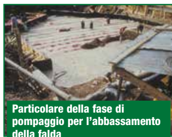
Posa del manto impermeabile direttamente sul magrone di fondo e successiva protezione con cappa
