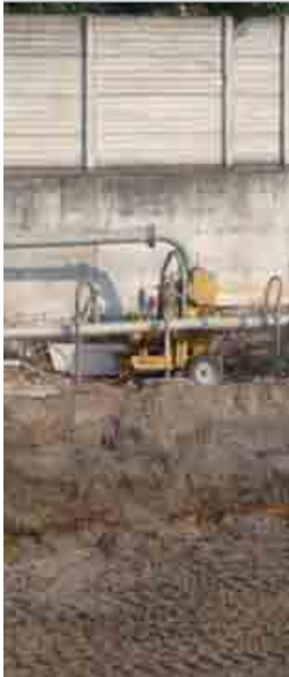
Fig. 3.7 - Pompa autoadescante utilizzata nel sistema wellpoint
