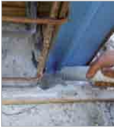
Fig. 7.56d - Sigillatura con MAPEPROOF SWELL
