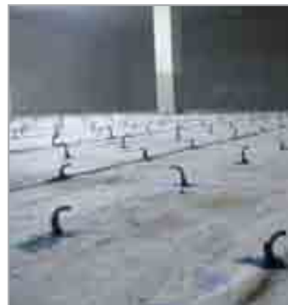
Fig. 8.6g - Connettori metallici stuccati prima del posizionamento delle armature della nuova soletta da realizzare
