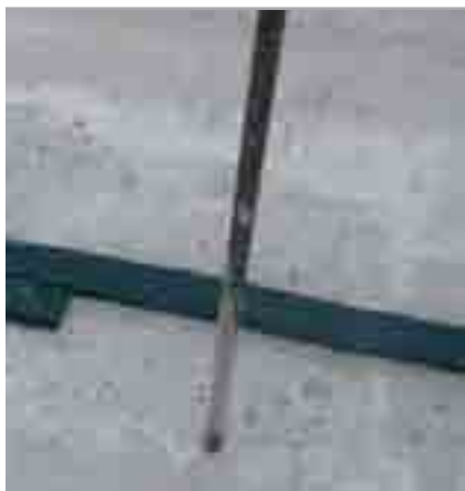
Fig. 7.3 - Giunzione tra due capi di IDROSTOP B25 per semplice accostamento laterale di almeno 6 cm
