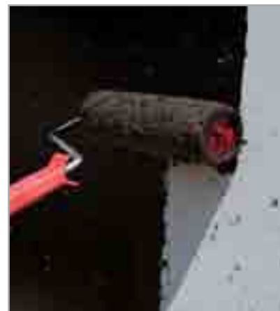
Fig. 7.51 - Applicazione a rullo di PLASTIMUL PRIMER
