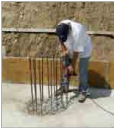
Fig. 7.15 - Scapitozzatura della testa del palo
