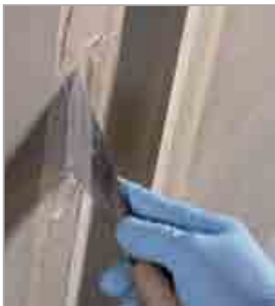
Fig. 7.48d - Stesura a spatola del secondo strato di ADESILEX PG4
