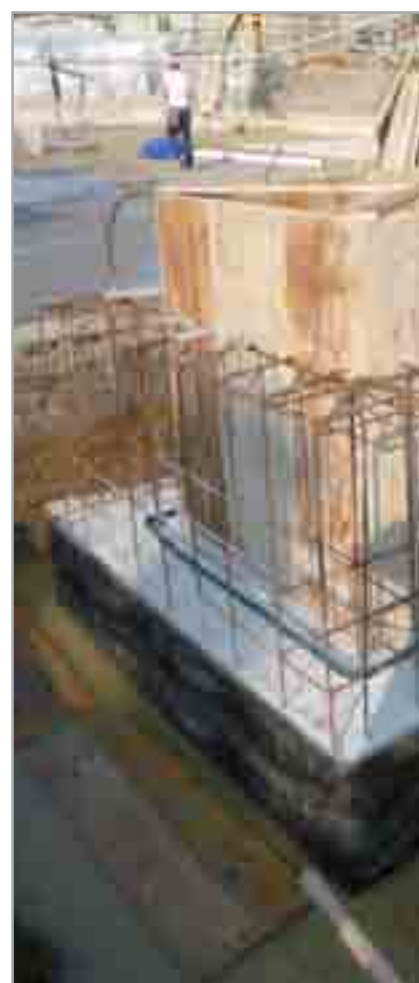
Fig. 7.7 - Impermeabilizzazione di una fossa ascensore realizzata all'interno di uno scavo di sbancamento
