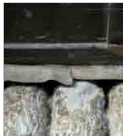
Fig. 7.74 - MAPEPROOF, applicato prima del getto del solaio, viene risvoltato per garantire il sormonto con quello che verrà successivamente posato sulla superficie verticale
