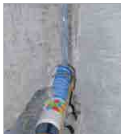
Fig. 8.1b - Estrusione di MAPEPROOF SWELL
