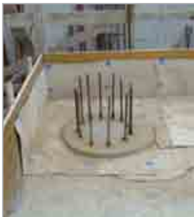
Fig. 7.20 - MAPEPROOF sagomato intorno alla testa del palo
