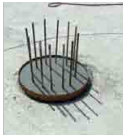
Fig. 7.17 - Testa del palo ricostruita con MAPEGROUT COLABILE
