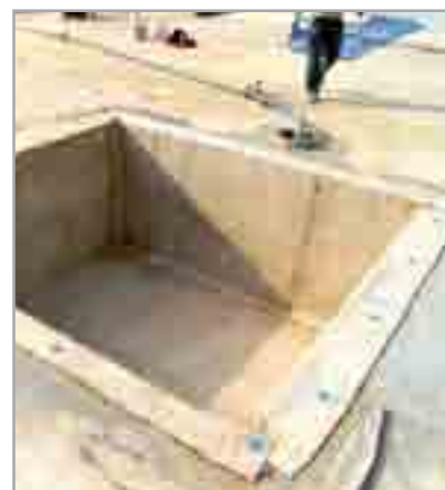
Fig. 7.5b - Fossa ascensore rivestita con MAPEPROOF
