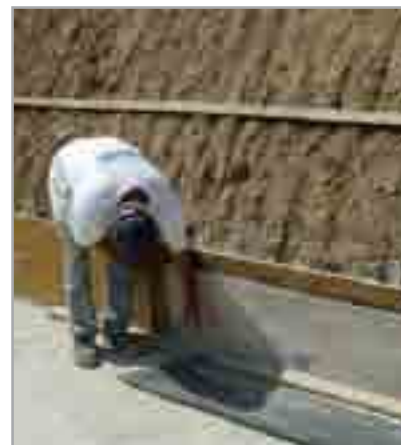
Fig. 7.10 - Chiodatura di MAPEPROOF su un cassero in legno
