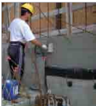
Fig. 7.70 - Applicazione di MAPELASTIC FOUNDATION sulla trave di coronamento della paratia
