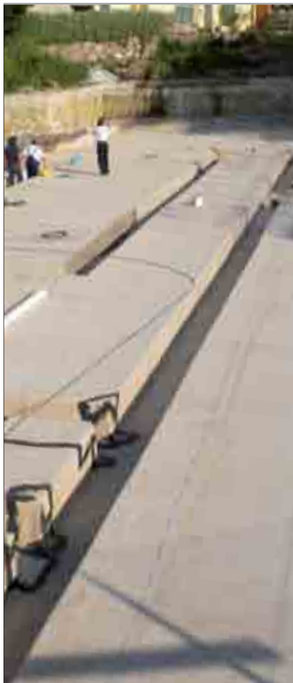
Fig. 7.12 - Stesura di MAPEPROOF mediante l'impiego di un bilancino metallico
