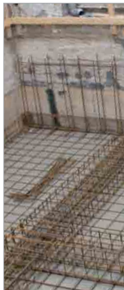
Fig. 8.5b - Dopo aver posato il telo anche sull'orizzontale, vengono posate le armature per il getto della soletta e delle contropareti in c.a.
