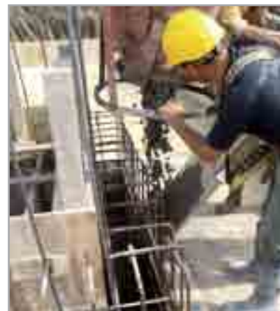
Fig. 7.5f - Getto delle pareti verticali
