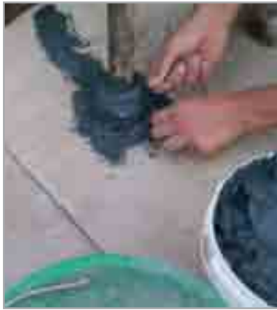
Fig. 7.60d - Fissaggio di IDROSTOP B25 mediante filo metallico
