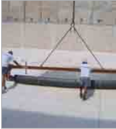
Fig. 7.12 - Stesura di MAPEPROOF mediante l'impiego di un bilancino metallico
