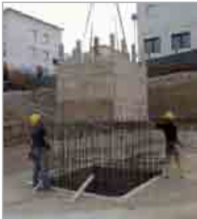
Fig. 7.5e - Posizionamento dei casseri in legno previa sigillatura della ripresa di getto tra platea e pareti con IDROSTOP B25
