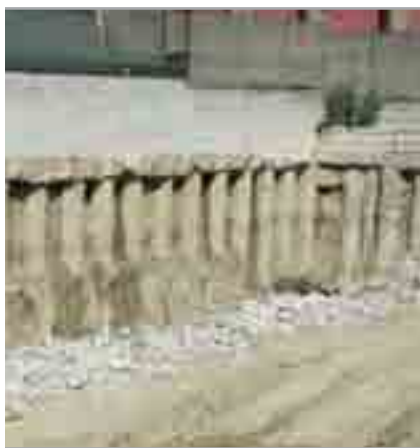
Fig. 4.3 - Scavo di sbancamento confinato mediante pali trivellati
