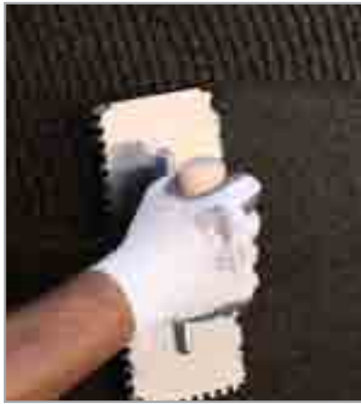
Fig. 7.53 - Applicazione di PLASTIMUL 2K PLUS
