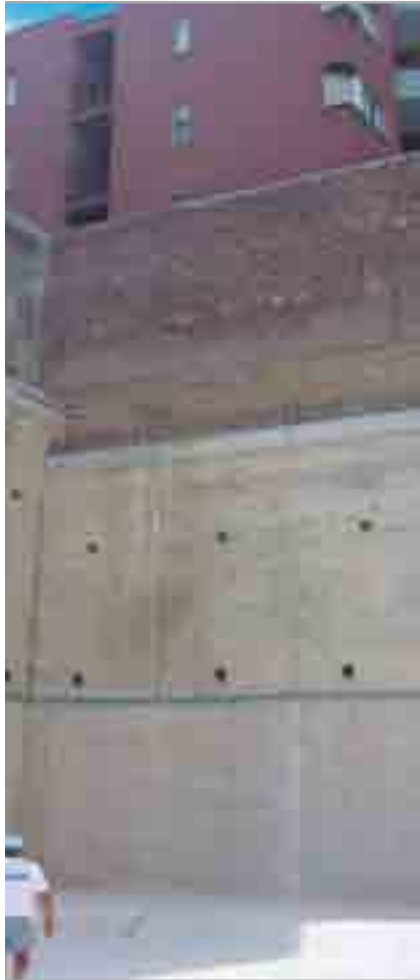
Fig. 4.2 - Scavo di sbancamento confinato mediante diaframmi
