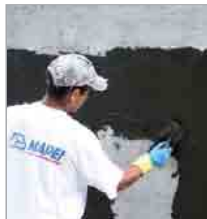
Fig. 7.50 - Applicazione a spatola di PLASTIMUL su una parete verticale controterra
