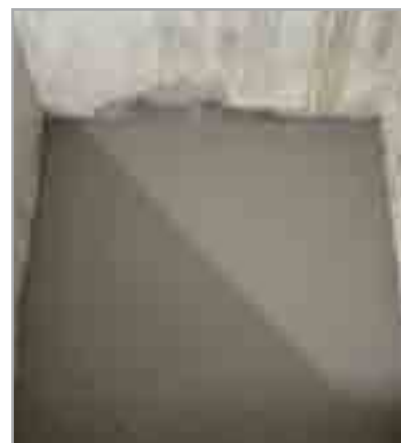
Fig. 8.8b - Massetto composto di sabbia-cemento e IDROSILEX
