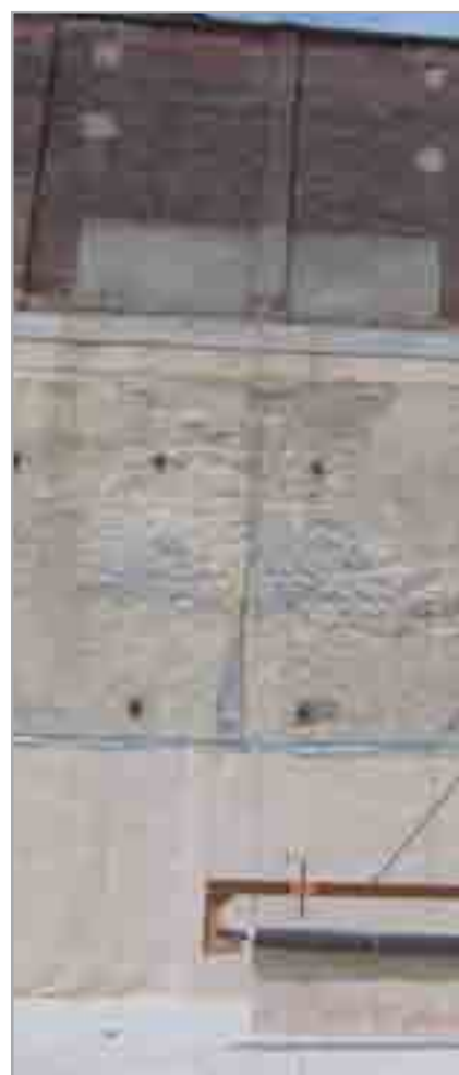
Fig. 7.37 - Posa di MAPEPROOF contro un diaframma
