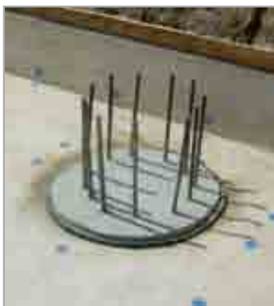
Fig. 7.21 - Applicazione di IDROSTOP B25 intorno alla testa del palo
