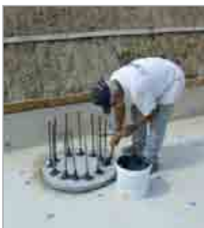
Fig. 7.22 - Stuccatura delle armature del palo con MAPEPROOF MASTIC
