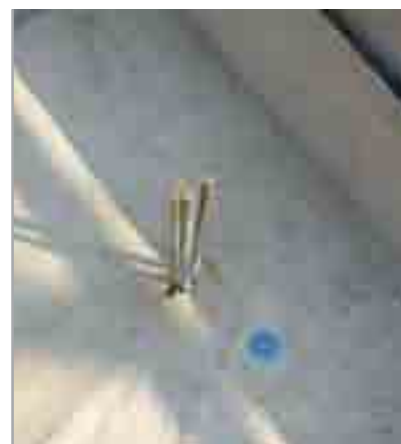
Fig. 7.24 - MAPEPROOF attraversato dalle armature del palo
