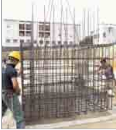
Fig. 7.5c - Posizionamento delle armature
