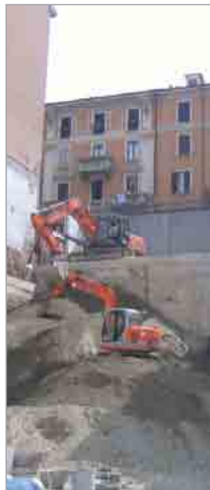
Fig. 1.1 - Fasi di scavo per la realizzazione di una costruzione interrata in presenza di fabbricati limitrofi
