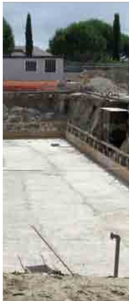
Fig. 4.1 - Scavo di sbancamento non confinato
