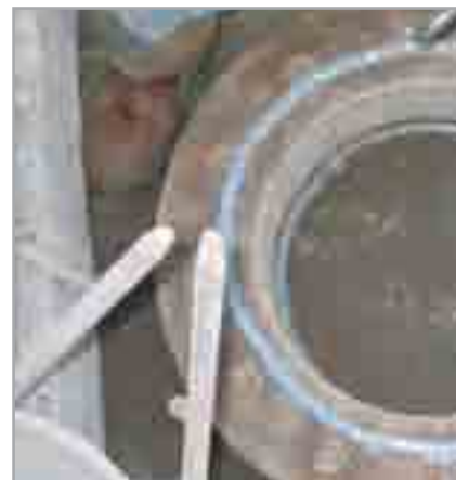
Fig. 7.61 - Estrusione di MAPEPROOF SWELL per sigillare la connessione tra chiusino e pozzo
