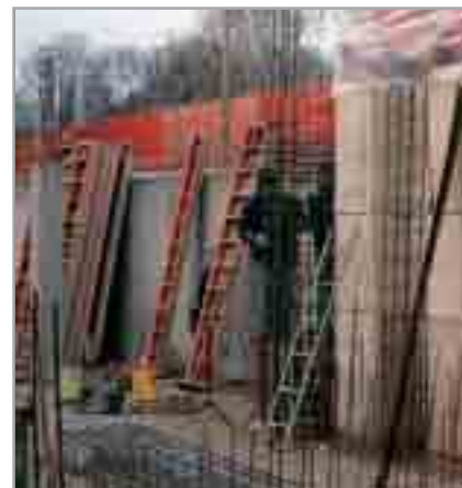
Fig. 7.31 - Applicazione di MAPEPROOF direttamente sulle palancole
