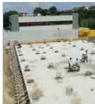
Fig. 7.18 - Visione d'insieme di una serie di pali nella fase di ricostruzione della testa di ciascuno
