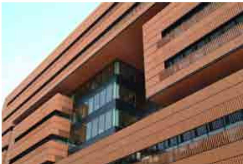
5. Installazione esterna fissa: dispositivi frangisole verticali “passivi”.
