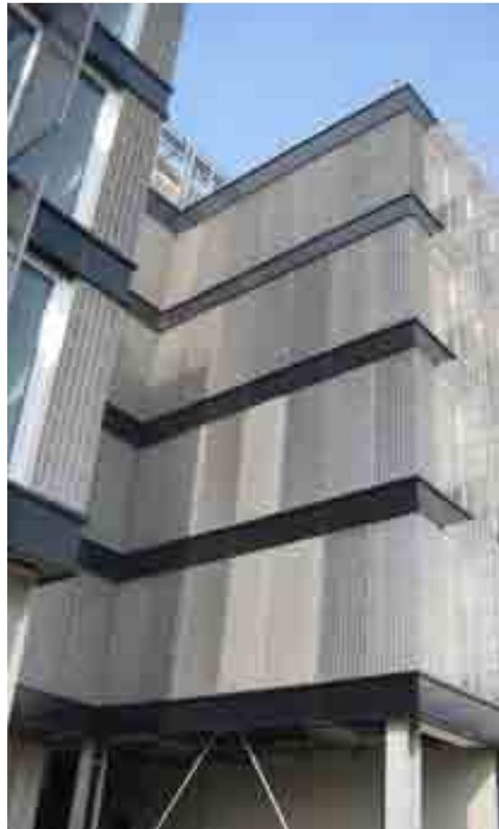
12. Installazione esterna mobile: dispositivi orientabili azimutali.
