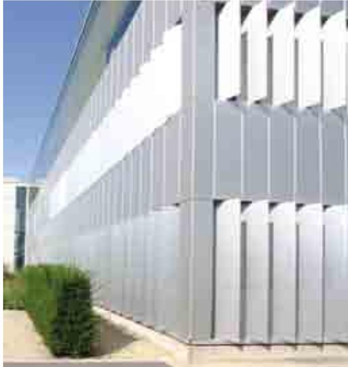
4. Installazione esterna fissa: dispositivi frangisole verticali “passivi”.
