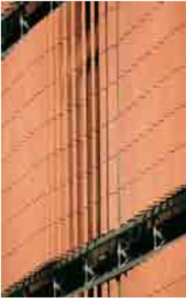
6. Installazione esterna fissa: dispositivi frangisole verticali "passivi".
