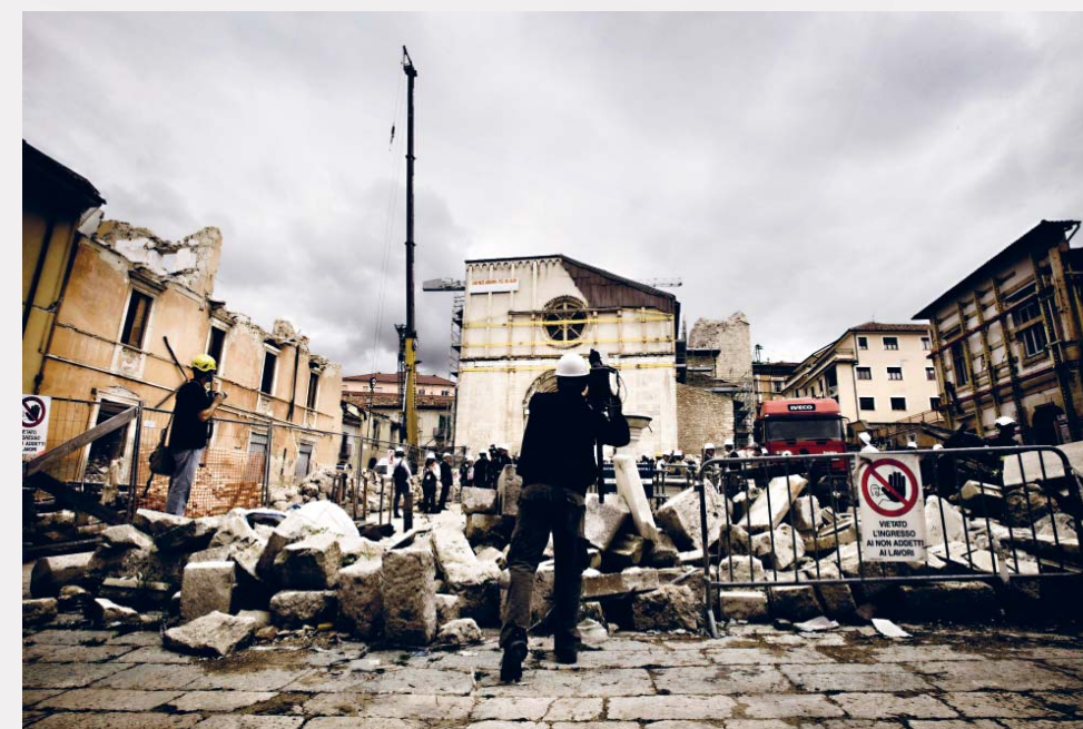
L'Aquila, La piazza centrale dopo il terremoto del 2009, durante le fasi di rilievo e documentazione dei danni. L'Aquila, the city's main square after the 2009 earthquake, during the survey and documentation of damage.
