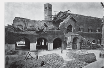
Il palazzo dei Trecento a Treviso, colpito dai bombardamenti bellici: le zone ricostruite sono evidenziate da un abbassamento di tonalità cromatica dei mattoni, da una soluzione di continuità nel margine di connessione e da conci recanti la datazione, nel pieno rispetto delle indicazioni della carta di Atene del 1931. Palazzo dei Trecento in Treviso, bombed during WWII: the rebuilt sections are marked by a fading of masonry colour, seamless connection at the edge and dated ashlar, in full compliance with the directions of the Athens Charter of 1931.
