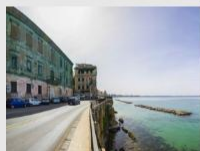
CONVENTO SAN DOMENICO MAGGIORE MONTELIVETO
