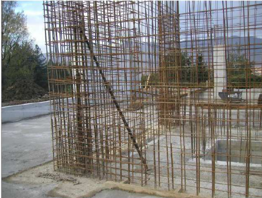
Esempio di setto sismo-resistente
