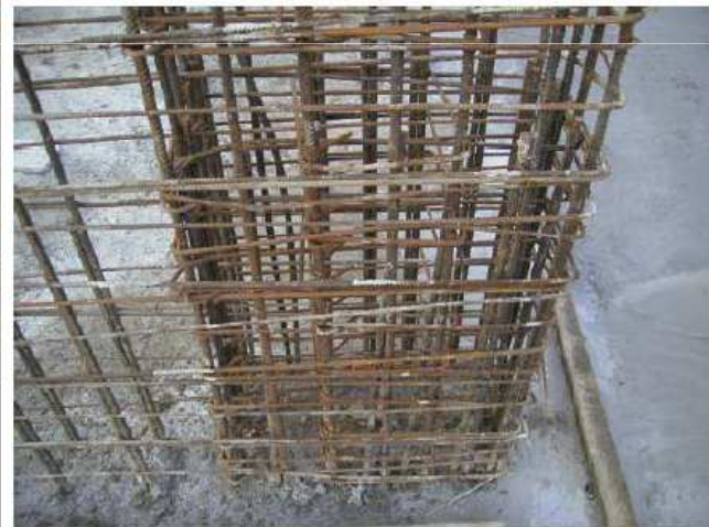
Dettagli armatura nello spigolo
