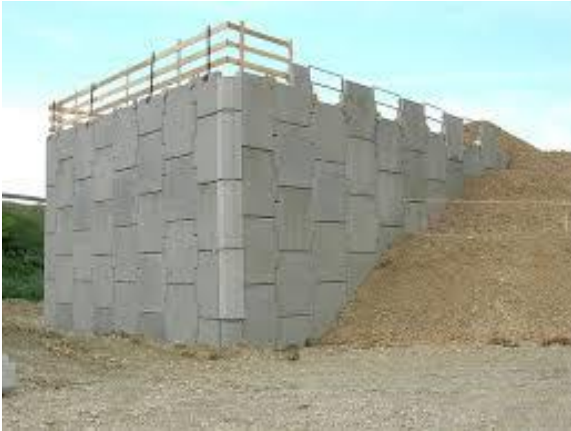
Terra armata: spalla di un cavalcavia
