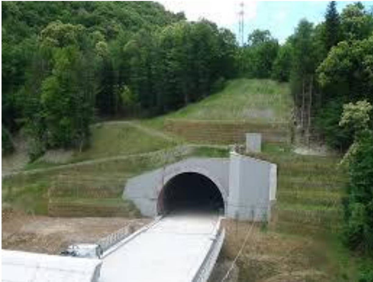
Terra armata Imbocco galleria
