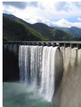
Pompaggio dell'acqua in invasi idrici
