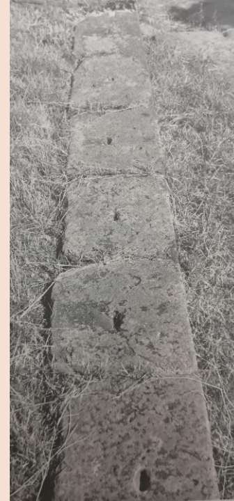
Tempio Giunione Lacinia, Agrigento. Orecchioni laterali incavati
