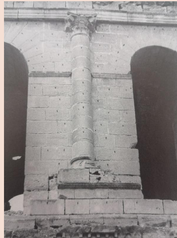
Fori per alloggiamento tenaglie nell'anfiteatro di El Jem
