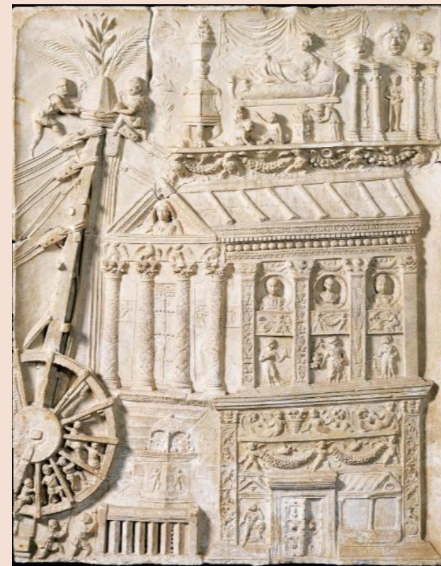
Tomba Haterii. Macchina di sollevamento di grande potenza, con 7 montanti muniti di paranchi e ruota cava azionata da 5 operai
