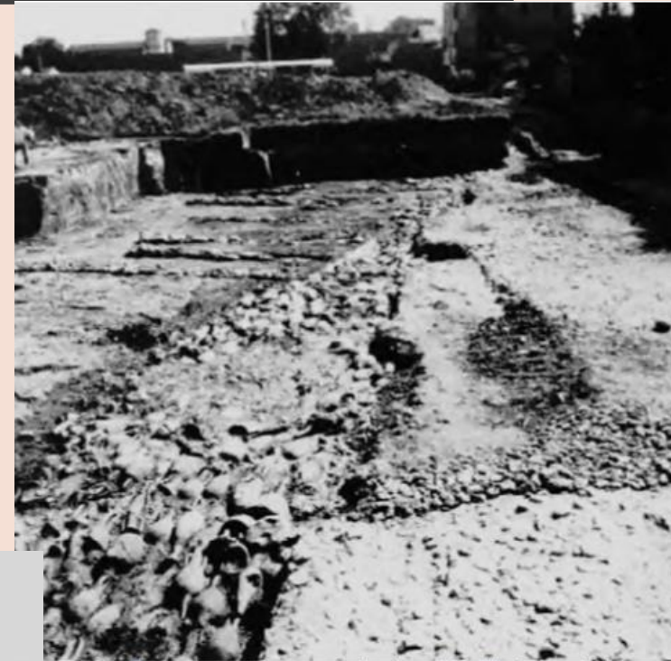
Fig. 2. Bonifica con anfore impiegata per sottofondare la massciata della via Parma-Brixellum
