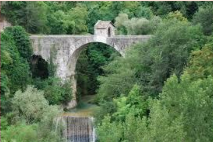
Via Salaria: Ponte di Cecco sul fiume Castellano (Ascoli Piceno), Età repubblicana
