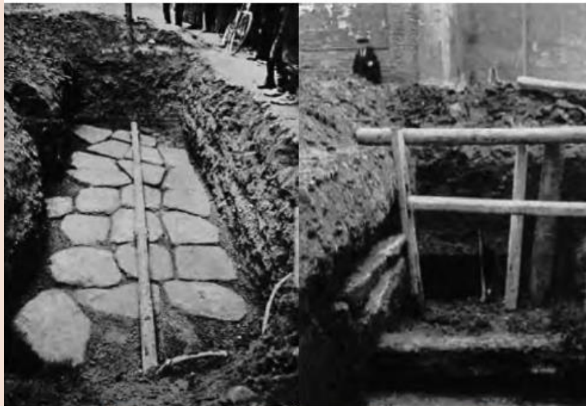
Fig. 3 Sottostruttura in legno della via Bononia-Hostilia messa in luce nel 1911
