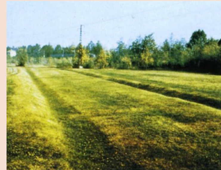
Val Padana, via terrena, fondo erboso su terrapieno delimitato da due fossati laterali per il drenaggio delle acque
