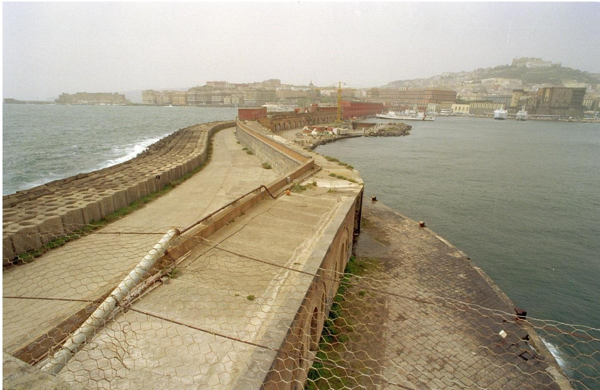
La costruzione di lunghe dighe foranee per i porti, e di barriere artificiali per la protezione delle spiagge, hanno spesso accentuato il fenomeno dell'erosione, perché impediscono il naturale trasferimento di materiale lungo costa
