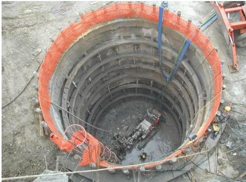
Fondazioni a pozzo (ciclopiche) sono costituite da scavi a sezione obbligata profondi, riempiti con materiale arido accuratamente costipato o conglomerato cementizio a basso tenore di cemento.
