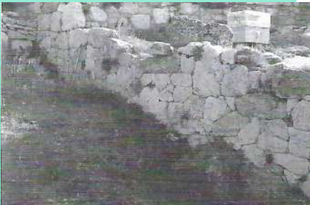
Muro poligonale di contenimento della rampa di accesso di età pisistratica (80x12m)
